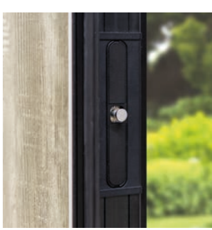
Dreidimensional verstellbares Schließteil im Türflügel
