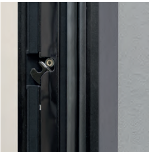
Der Verschluss mit pferdekopfförmiger Verriegelung im Rahmen
