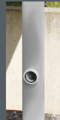
Entwässerung durch Stütze
